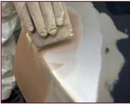
Несмотря на волокнистую структуру, шпатлевка DX84 легко разравнивается шпателем и не стекает с вертикальных поверхностей.
